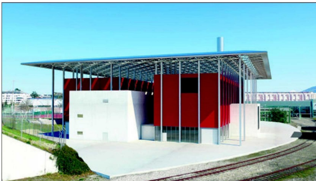
La future centrale à gaz du Lignon. Le bâtiment qui abritera une installation de production d'électricité et de chauffage à distance, sera en outre équipé de panneaux photovoltaïques sur le toit. (DR)
